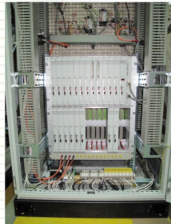
ПТС ОДУ включает МПКУ, крейты А и В ( до 14 ФМ), кросс оптический, конверторы, звуковой излучатель, клеммы для подключения цепей внешнего питания (1L+, 2L+, M1, M2), клеммы для подключения цепей синхронизации (BS), блок питания (24В/5В), автоматические выключатели.
